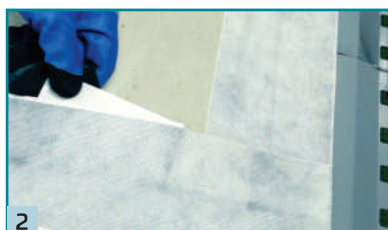
2 Překlenutí styčné spáry potěru a lemování pomocí samolepící pásky BD.
