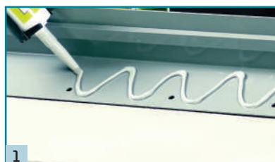
1 Fixace lemování k podkladu pomocí produktu MS6, nebo R70.
