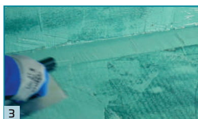
3 Provedení tenké uzavírající vrstvy reaktivní hydroizolační stěrkou RD2 The Green 1 na zvlhčený podklad.
