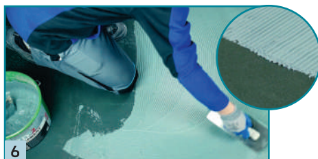
6 Provádění 2. vrstvy hydroizolační stěrkou RD2 The Green 1, na vytvrzenou první vrstvu.
