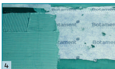
4 Uložení izolačního pásu PB do reaktivní hydroizolační stěrky RD2 The Green 1.
