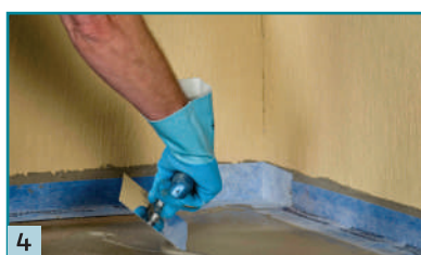
4 Nanášení izolační stěrky MD1 Speed nebo Multiproof ve dvou vrstvách.
