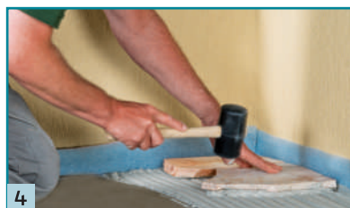
4 Kladení nekalibrovaných přírodních kamenů do lepicího lůžka tmelu MULTISTONE / M29 HP.
