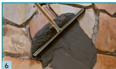
6 Spárování produktem MULTIFUGE Base.
