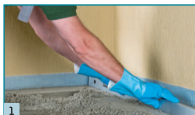
1 Vytvoření spádové vrstvy se sklonem min. 1,5 až 2 % produktem M100.
