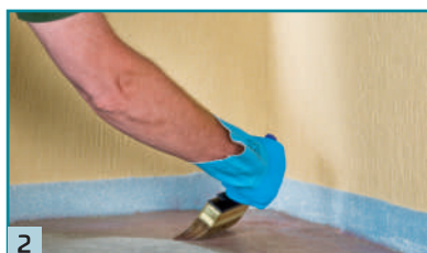
2 Penetrace podkladu nátěrem D11.
