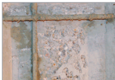
Protikorozní vrstvu BOTAMENT® Renovation HB 1 nechat proschnout
