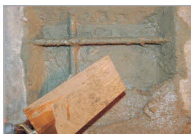
Opravnou maltu BOTAMENT® M 03 nanášet do čerstvého kontaktního můstku
