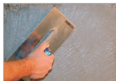
Vyhlazení povrchu jemnou stěrkou BOTAMENT® M 57
