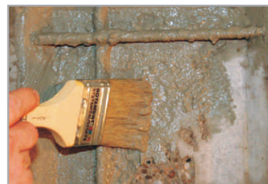
Povrch betonu důkladně zvlhčit a vytvořit kontaktní nátěr BOTAMENT® Renovation HB 1
